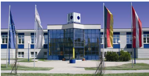
Unternehmenszentrale Kottlingbrunn, Österreich
