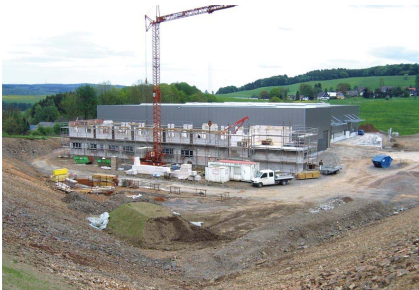
Baufortschritt in Meinerzhagen am 11. Mai 2009.
